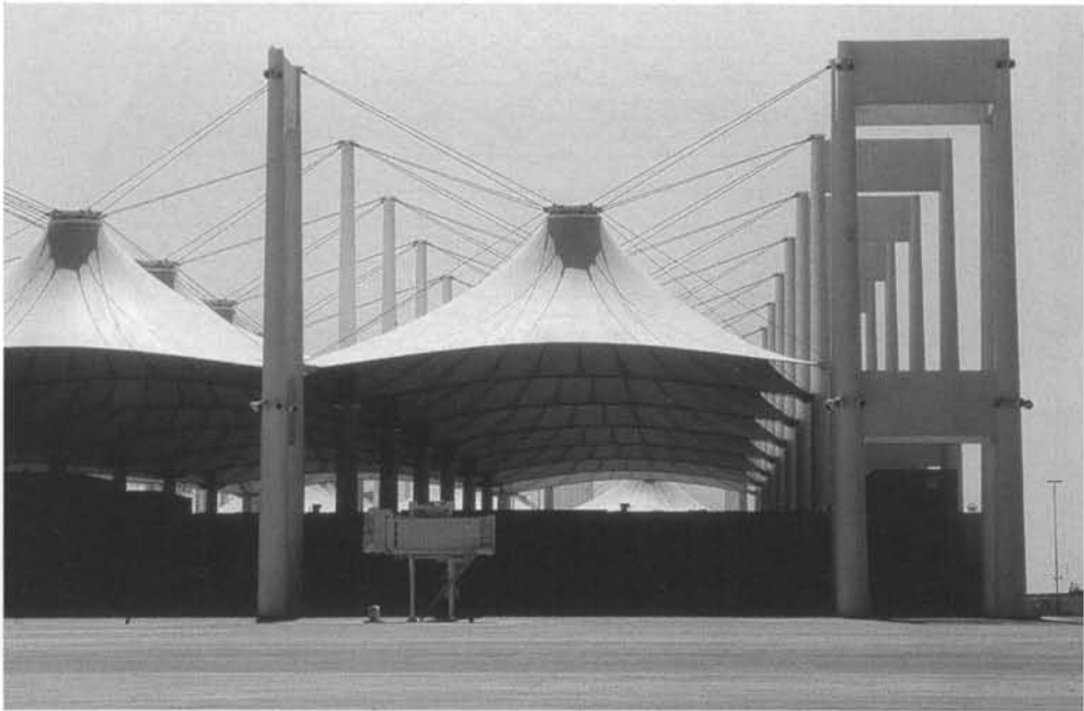
Fig. 1.15. The Haj Terminal, Jeddah, Saudi Arabia
